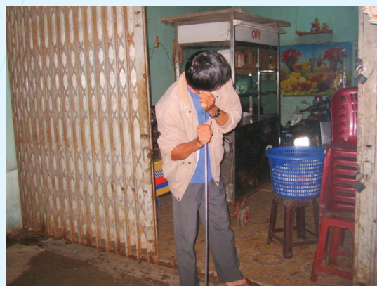
Hình 1. Nghe rò rỉ trên ống nước bằng ống nghe vào ban đêm
