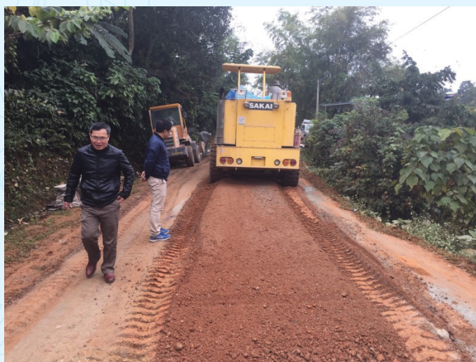
Hình 1: Phối trộn đất gia cố tại hiện trường
